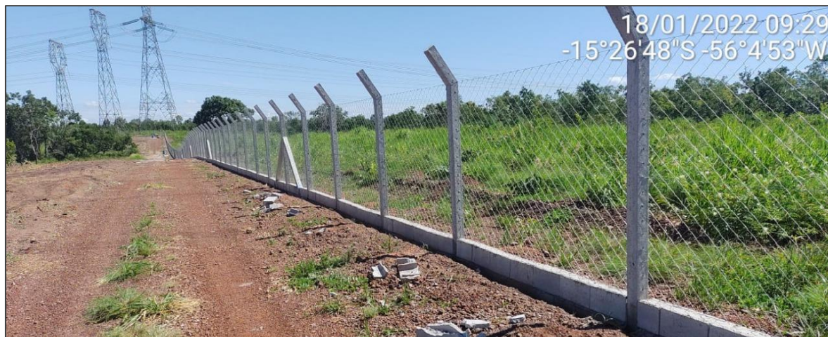
Foto do cercamento executado no Parque Novo Mato Grosso em Cuiabá - MT.
