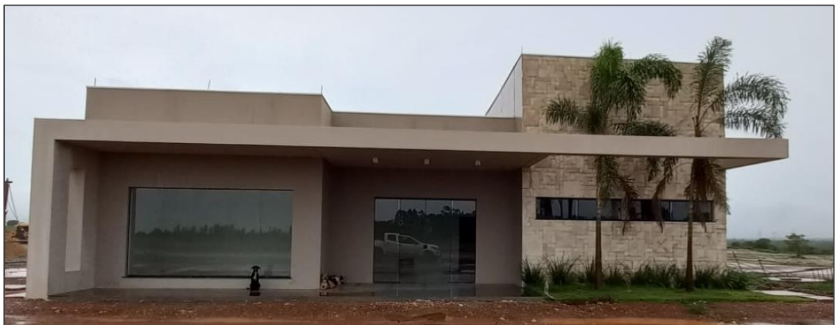
Modelagem e construção do bloco administrativo do Parque Novo Mato Grosso em Cuiabá - MT.
