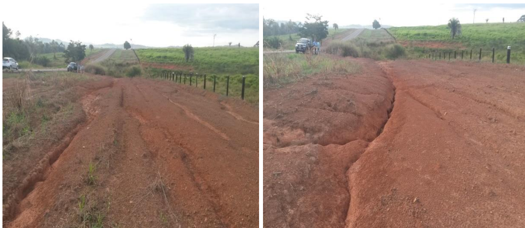
Foto 44 e 45: km 3,3 a km 3,25
