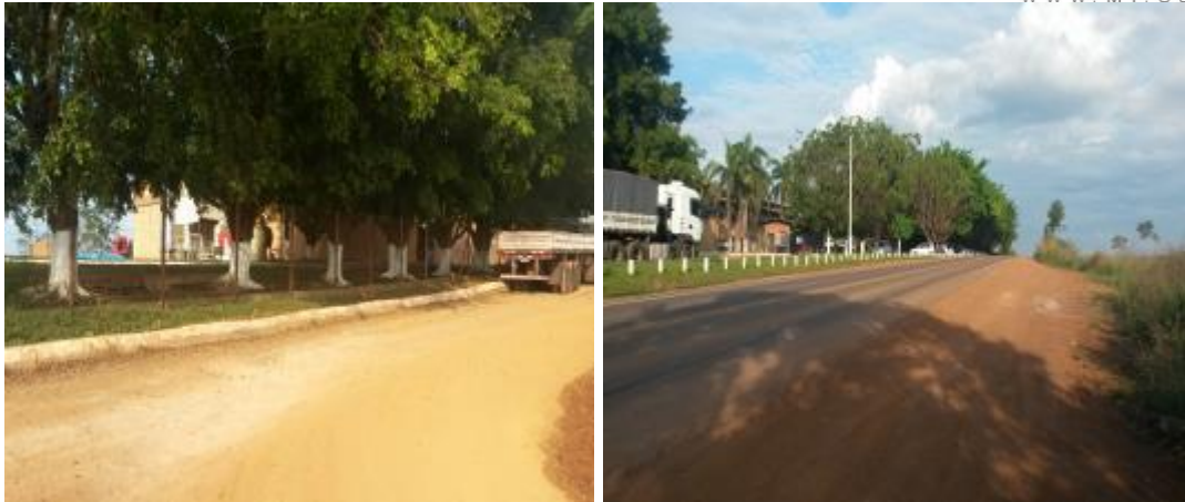
Foto 04 a 07 – Acesso a Indústria local no Trecho da MT-320.
