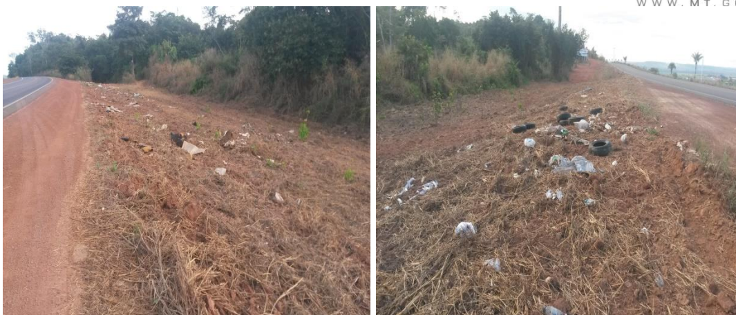
Foto 61 e 62: Km 7,7 a Km 7,57.
