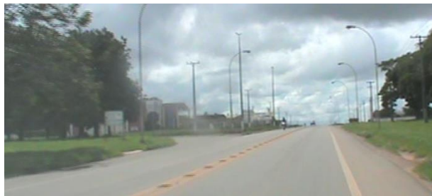
Figura 2: Trecho com pavimento e sinalização horizontal satisfatória, com presença de acostamento e proibição de ultrapassagem
