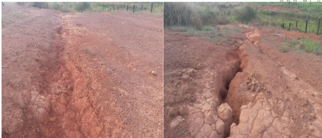
Foto 63 e 64: Km 30,1 a Km 29,60.
