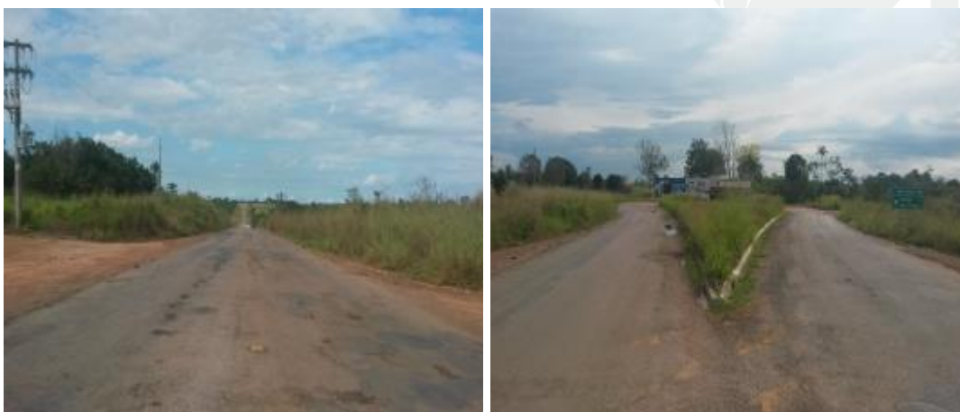
Foto 14 e 15 – Fim do Trecho da rodovia MT-320.
