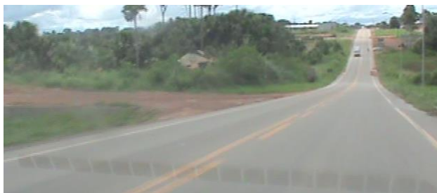
Figura 4: Trecho com pavimento e sinalização horizontal satisfatórios, sem presença de acostamento e permissão de ultrapassagem
