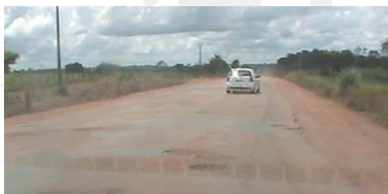
Figura 7: Trecho com pavimento completamente degradado e com ausência de sinalização horizontal e vertical.
