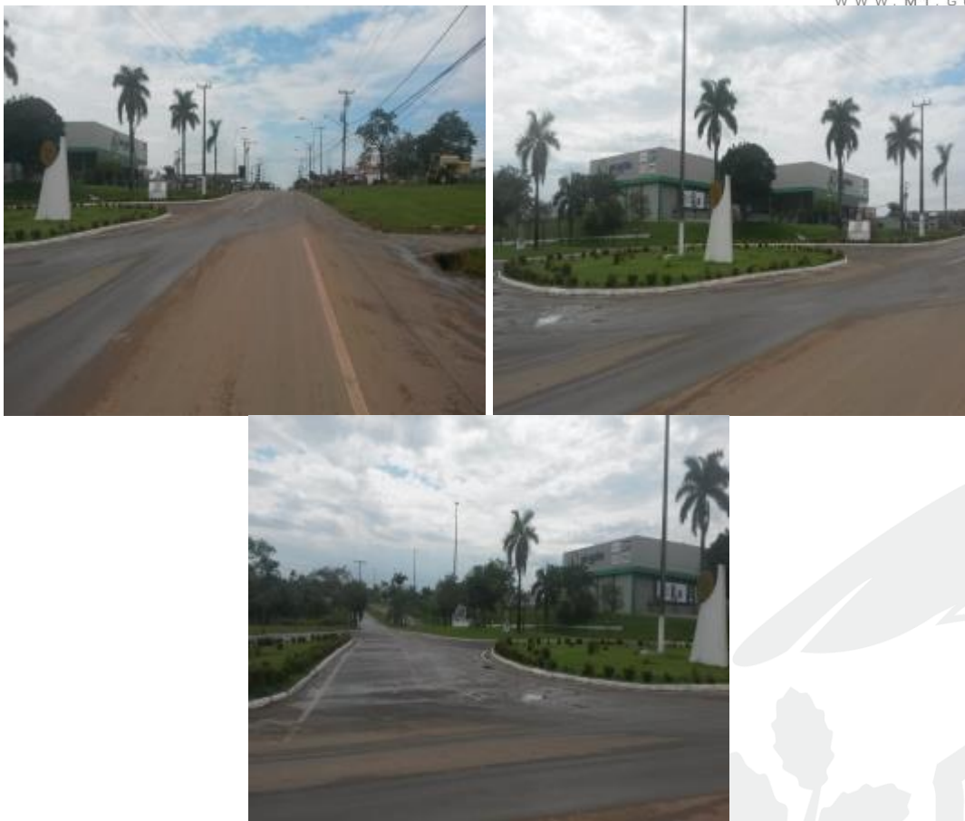
Foto 22 a 24 - Fim do Trecho da rodovia MT-208.
