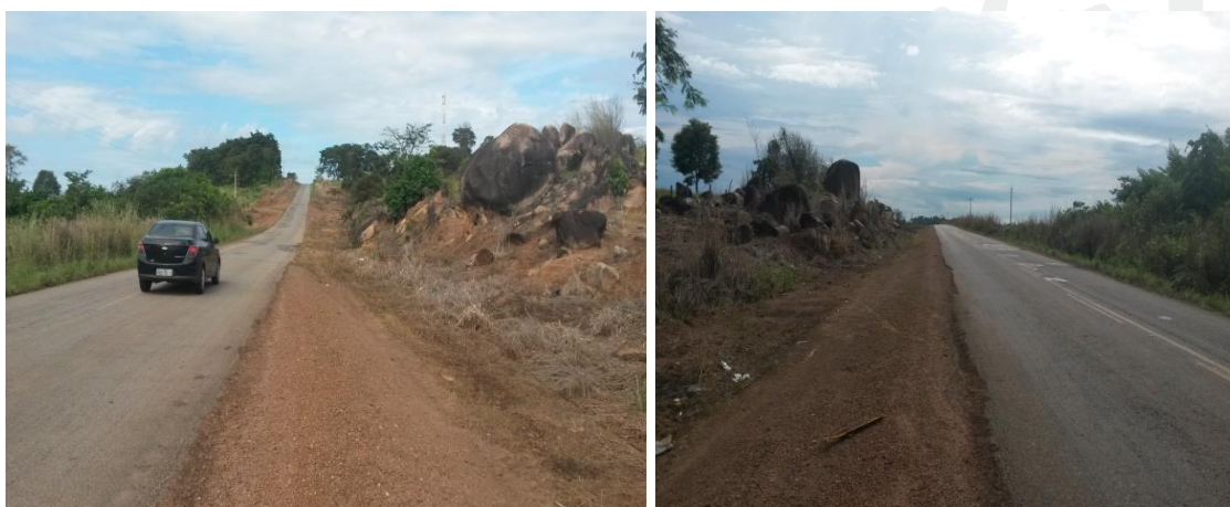
Foto 59 e 60: Km 149,7 a Km 147,23.
