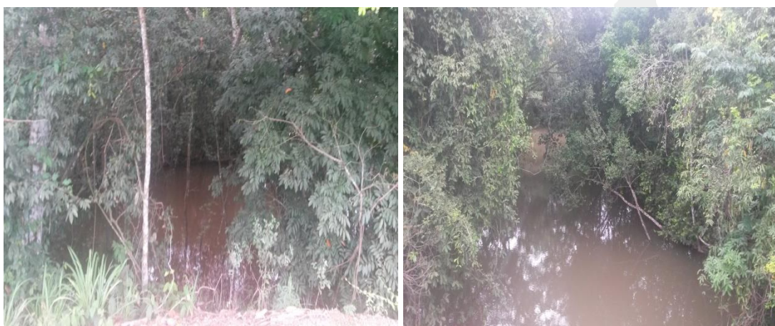
Foto 28 e 29 – Ponte implantada com intuito de manter o fluxo hídrico local.
