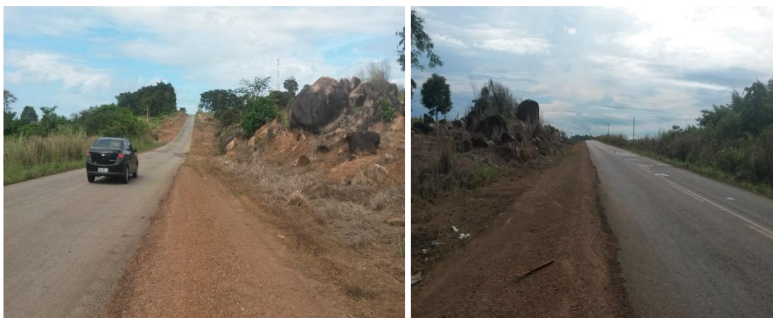
Foto 59 e 60: Km 149,7 a Km 147,23.
