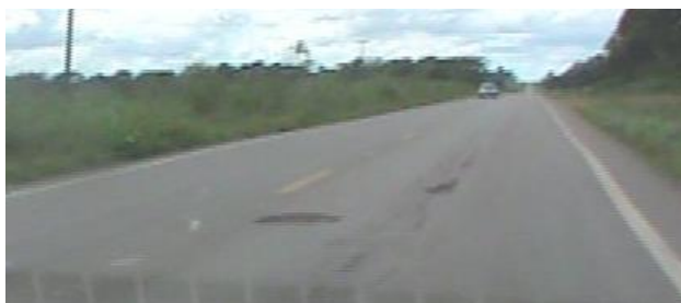
Figura 6: Trecho com pavimento carente de revitalização e sinalização horizontal regular.
