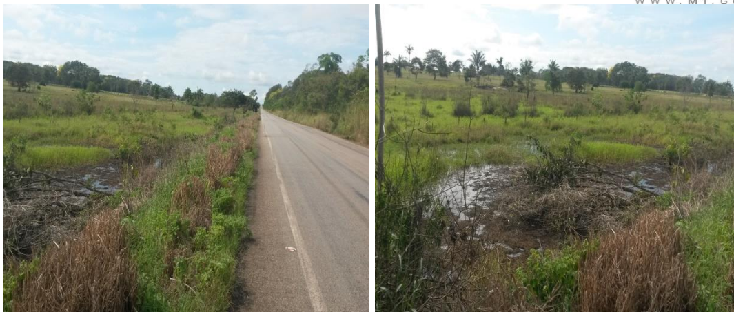
Foto 30 e 31 – Local com a presença de drenagem na faixa de domínio da rodovia.
