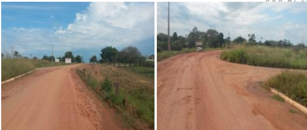
Foto 16 e 17 – Início do Trecho apresenta contorno para acesso da MT-208.
