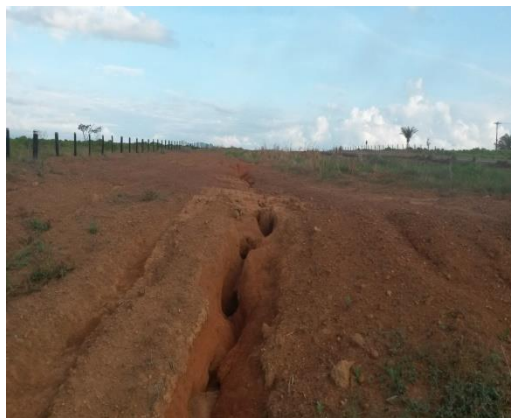
Foto 46 e 48: km 3,3 a km 3,25
